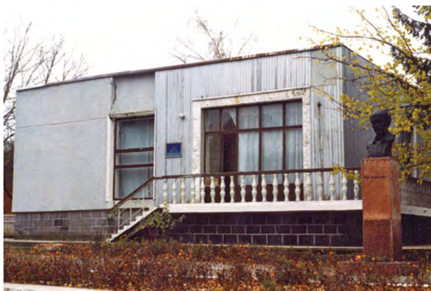
Приміщення музею до ремонту
